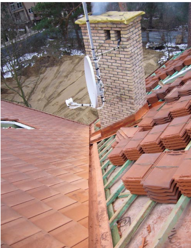
Długa obróbka podstawy komina, wchodząca w kosz
