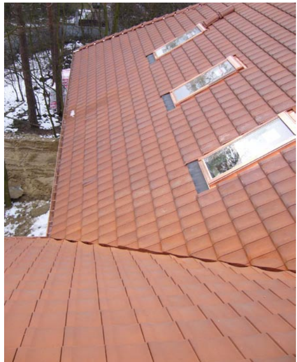
Rząd okapowy przebiegał zgodnie ze spadkiem rynny. Mimo to na połaci nie widać różnic w długości krycia dachówek. W rynnie wewnętrzne rynhaki
