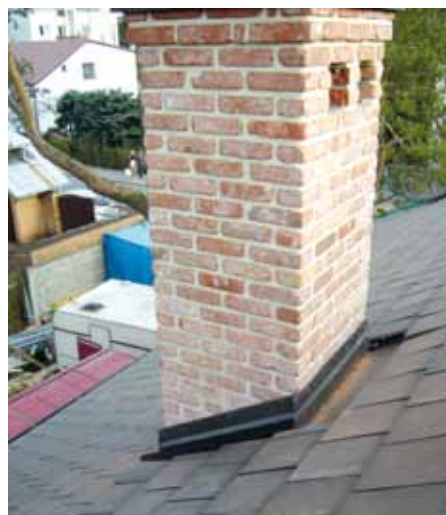
▲ ...i komin, wymurowanego z tej samej cegły, co elewacja
