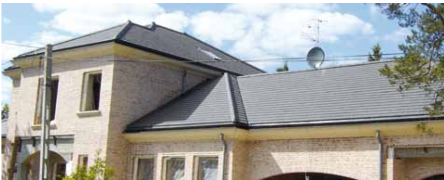
▲ Ceglana elewacja z ręcznie formowanej cegły i dach w kolorze tępka są ozdobą ulicy
