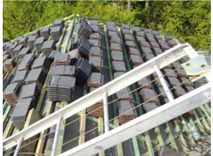
▲ Tu widać jednak, że to płaskie dachówki zakładkowe
