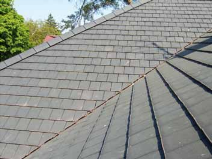
▲ Układane z przesunięciem dachówki mogą się kojarzyć z karpiówką
