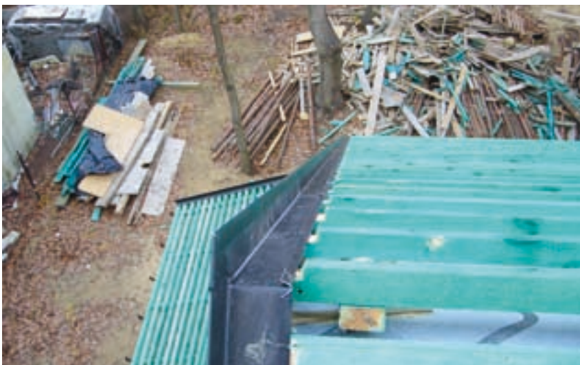
Szczyt — obróbka z tytanocynku
