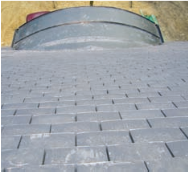
Lukarny przykryto blachą cynkowo-tytanową w kolorze dachówek
