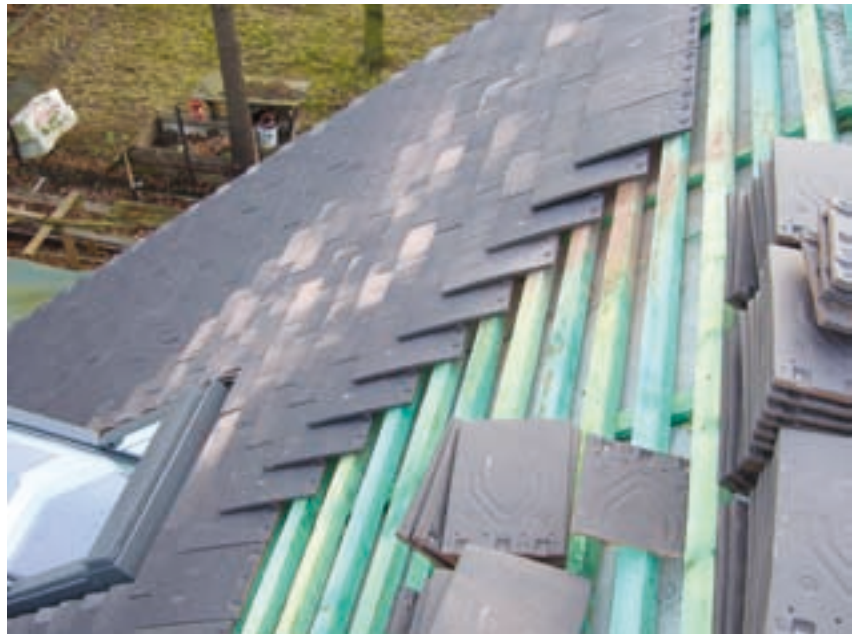
Tu wyraźnie widać wgłębienia w powierzchni dachówki
