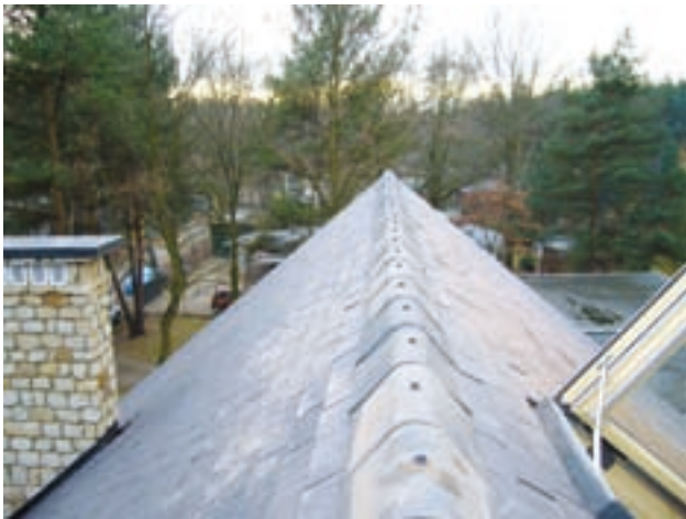
Kontrowersyjne krycie kalenicy. Wszystko zostało jednak wykonane zgodnie z zaleceniami producenta
