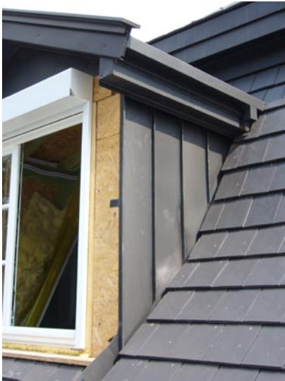
Zbliżenie zagłębianej obróbki bocznej ścianki lukarny
