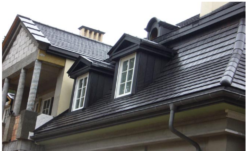
Na obróbce wszystkich lukarn użyto ponad 1300 mb blachy cynkowo-tytanowej
