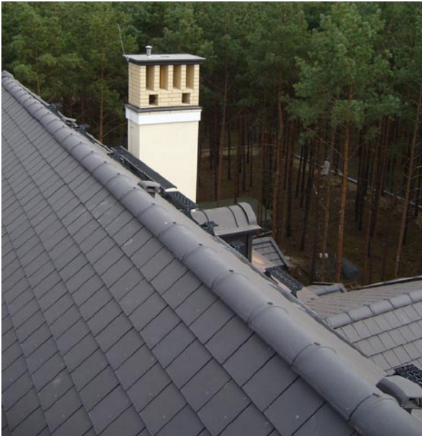
Kalenica, komin, stopnie kominiarskie oraz kominek wywiewny
