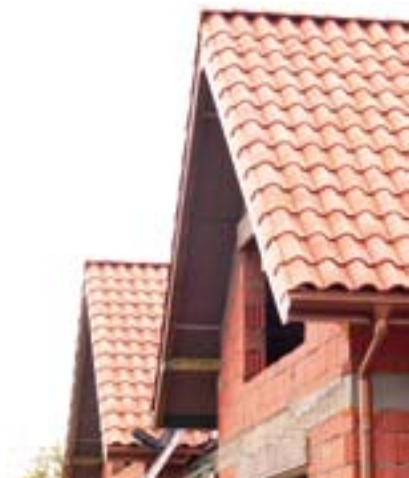
Szczyty frontowych wykuszy
