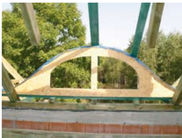
...i zamontowana w dachu
