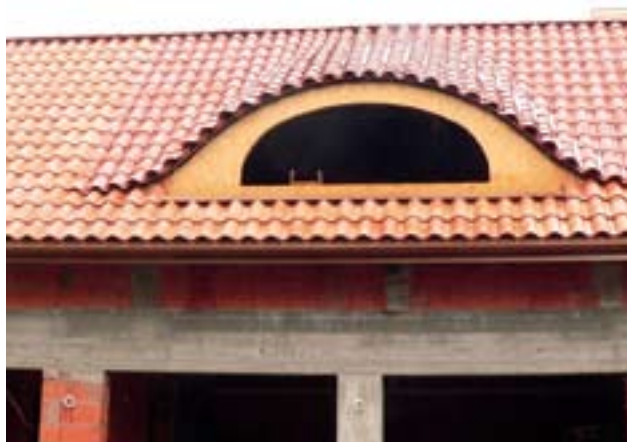
Wole oczka pokryto innymi dachówkami niż połacie, ale różnica jest niemal niedostrzegalna
