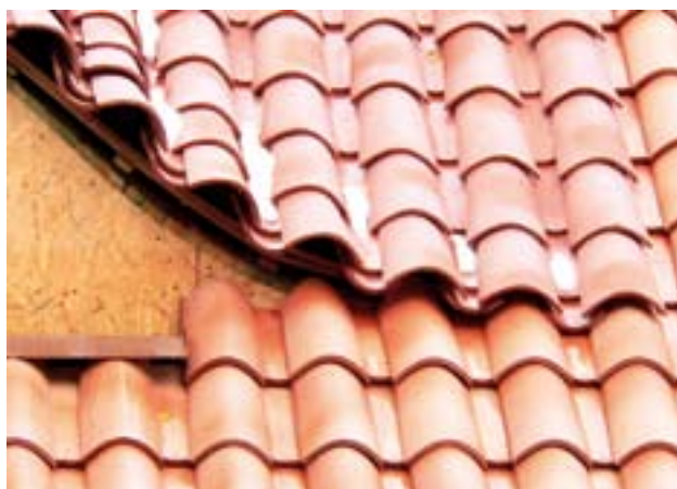
Połączenie lukarny z połacią
